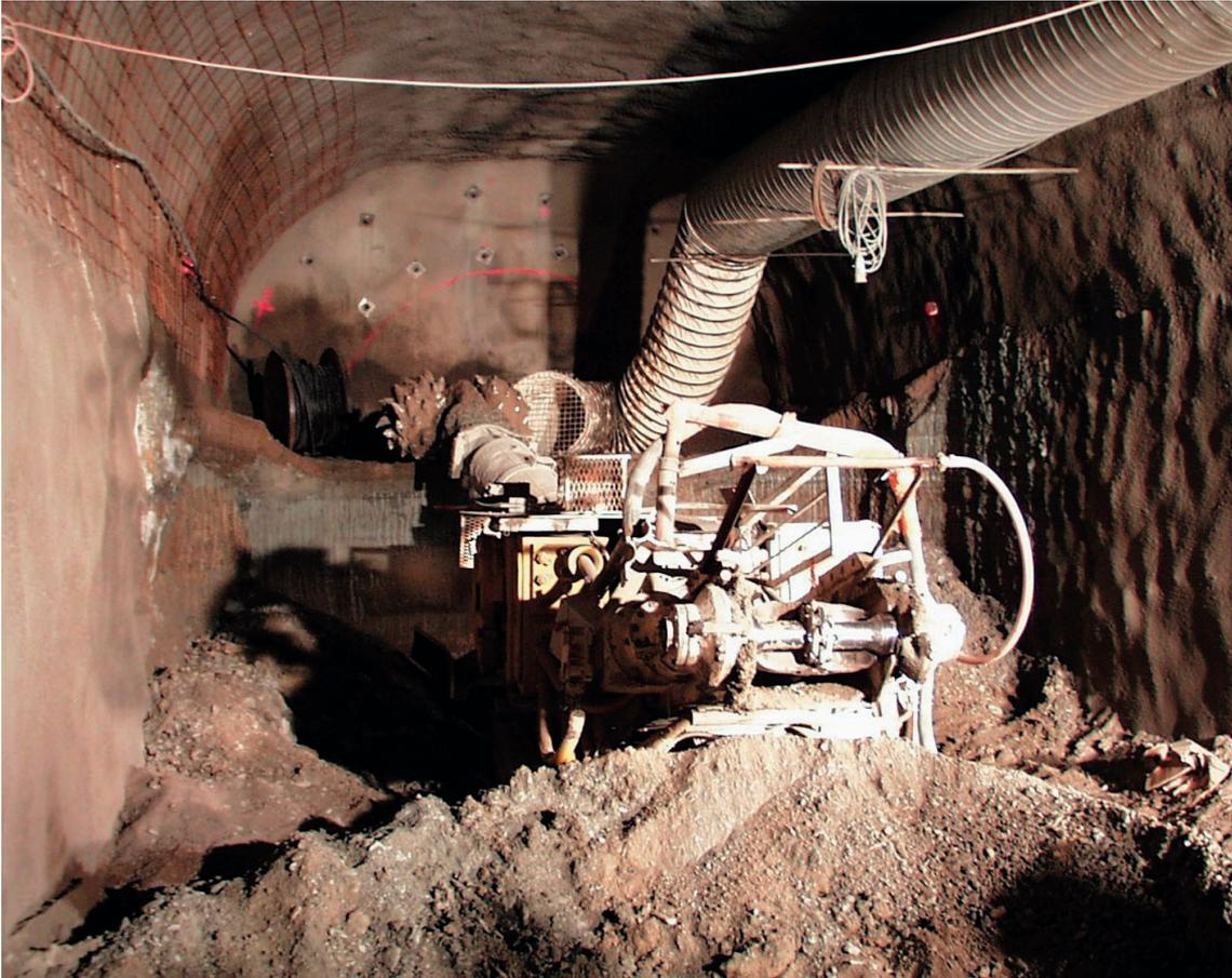
**Figure 15: Excavation par une haveuse à tête mobile**
